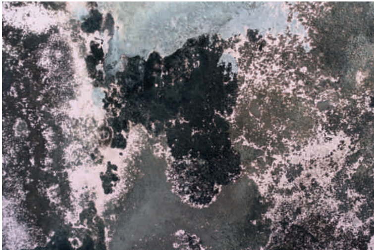
Das Ergebnis eines Wasserschadens mit Schimmelfall: Verschiedene Pilzgattungen und -arten überziehen mit ihren farbigen Fruchtkörpern die Wand und streuen Sporen
